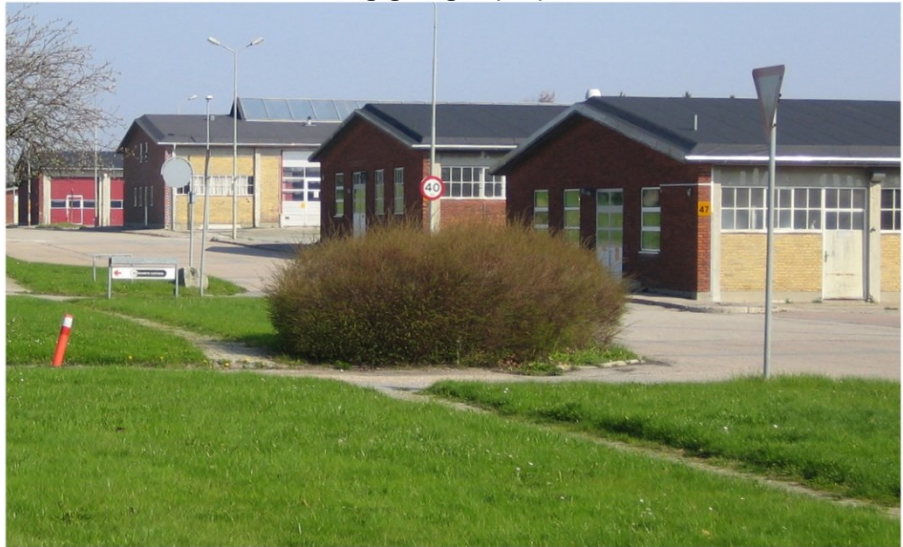
Figur 9: Bygninger i "værkstedsområdet" (bygn. 47, 48, 50 og 54)
