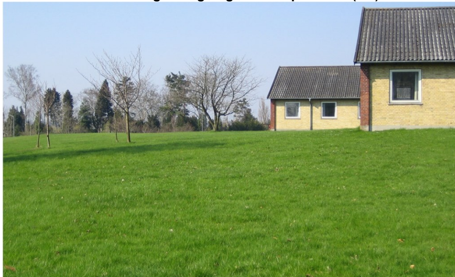
Figur 11: Belægningsbygninger for overordnede (byg. 3 og 4)
